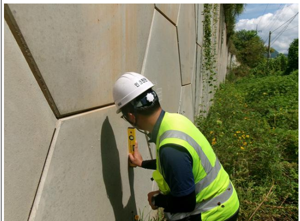
경사계를 이용한 경사도 측정
