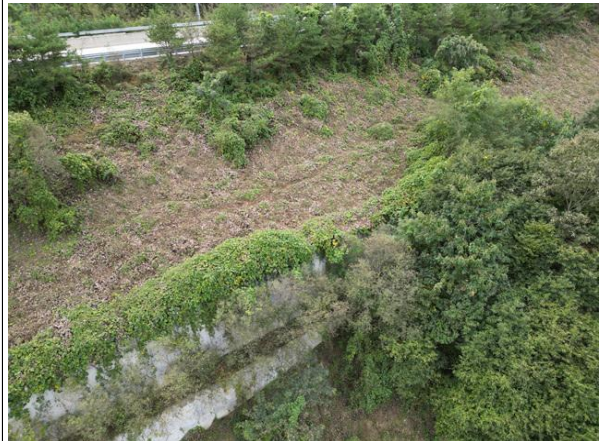
상부 성토부 전경
