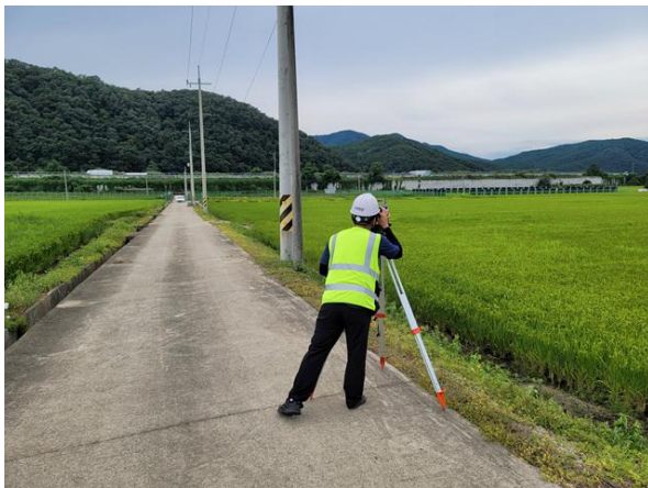
광파기를 이용한 측량 작업
