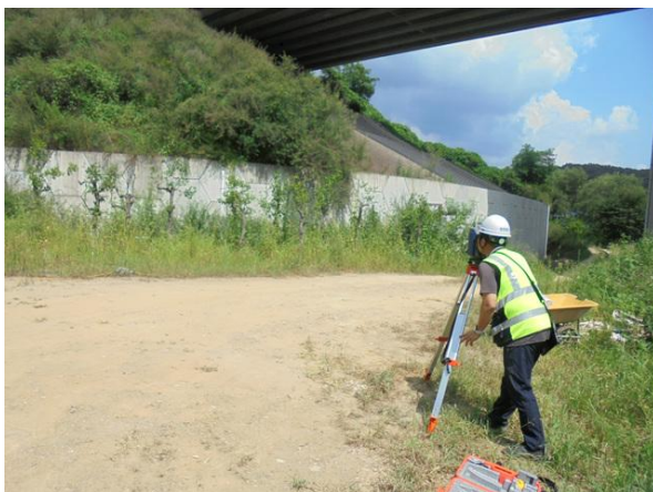
광파기를 이용한 측량 작업
