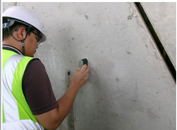
경사계를 이용한 경사도 측정
