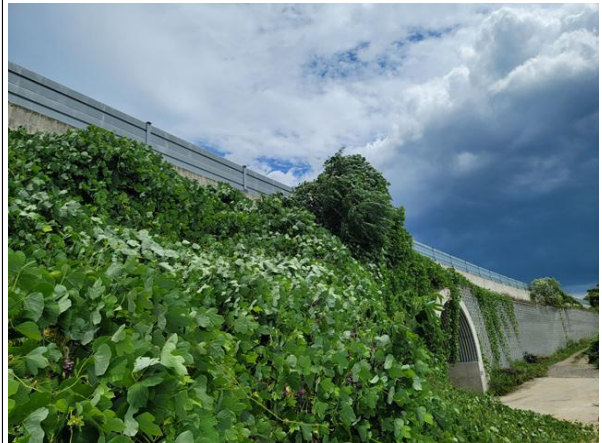
상부 성토부 전경
