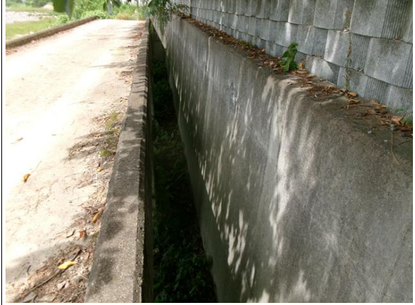
하부 배수로 전경
