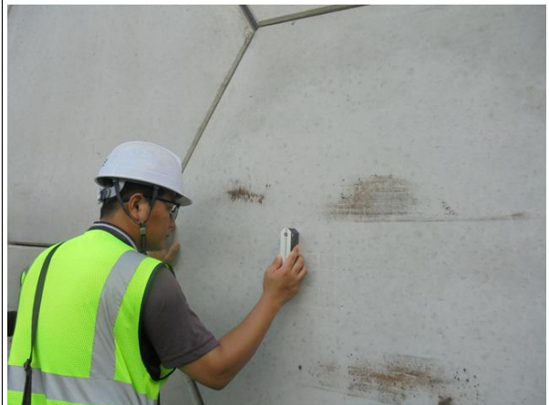
경사계를 이용한 경사도 측정
