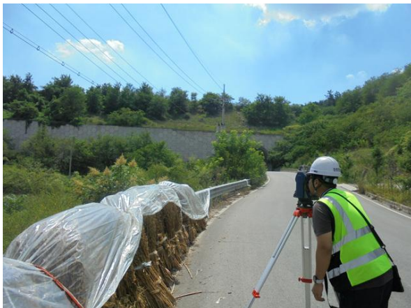
광파기를 이용한 측량 작업
