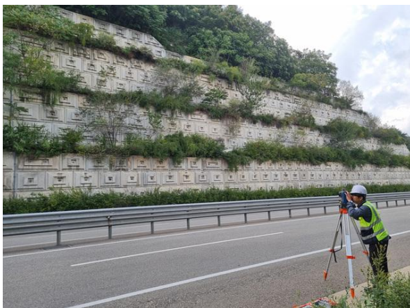
광파기를 이용한 측량 작업
