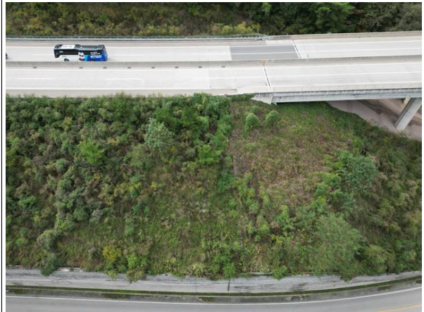
상부 성토부 전경
