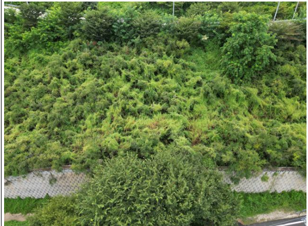
상부 성토부 전경
