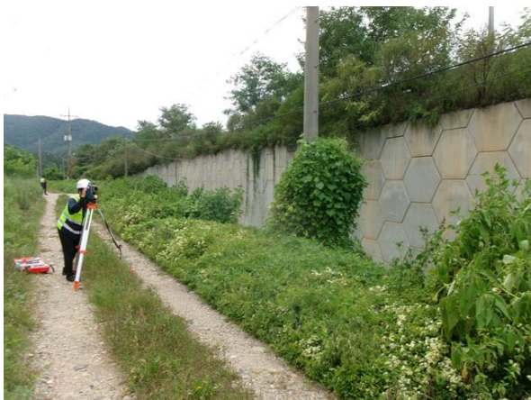
광파기를 이용한 측량 작업
