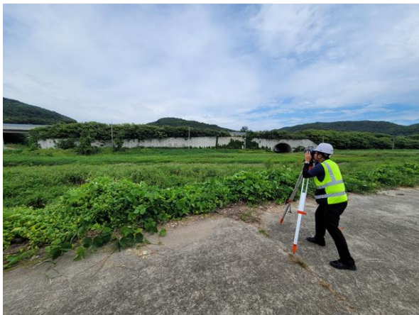
광파기를 이용한 측량 작업
