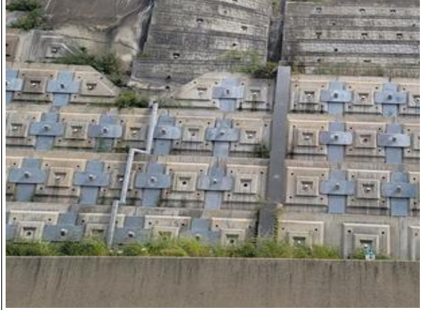
배수관, 배수로 전경
