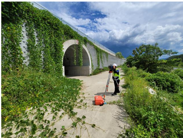
광파기를 이용한 측량 작업
