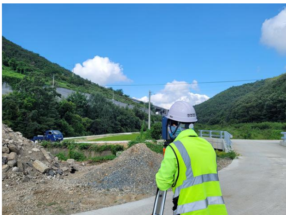
광파기를 이용한 측량 작업
