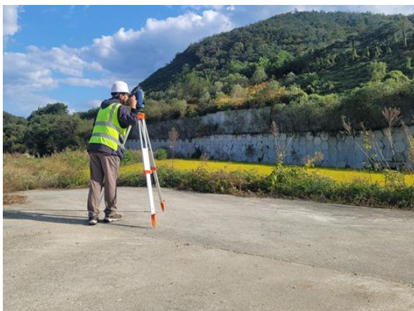
광파기를 이용한 측량 작업
