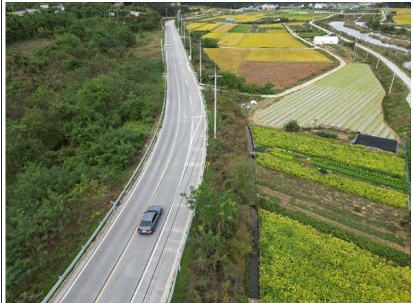
상부 성토부 전경
