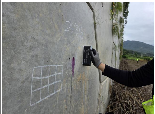
경사계를 이용한 경사도 측정
