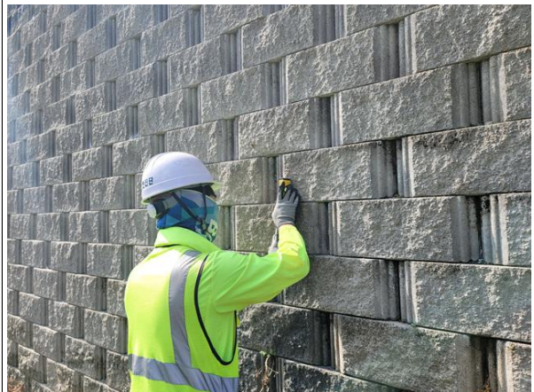
경사계를 이용한 경사도 측정
