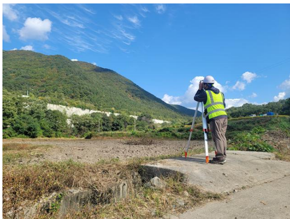
광파기를 이용한 측량 작업
