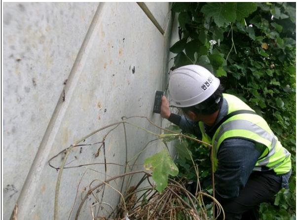
경사계를 이용한 경사도 측정
