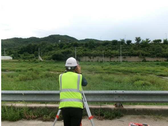
광파기를 이용한 측량 작업
