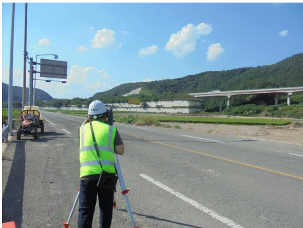
광파기를 이용한 측량 작업
