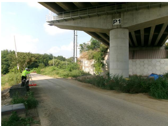
광파기를 이용한 측량 작업
