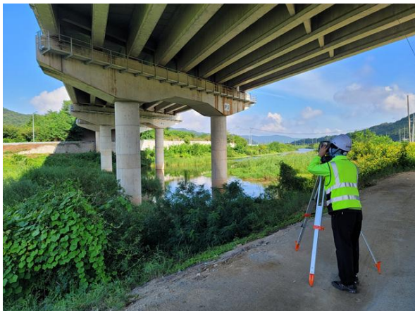
광파기를 이용한 측량 작업
