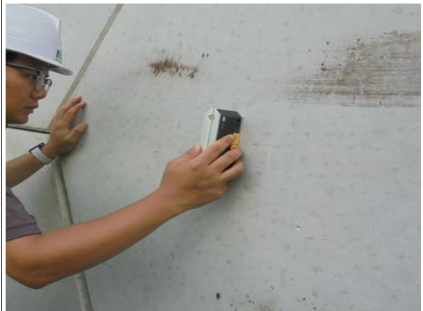
경사계를 이용한 경사도 측정
