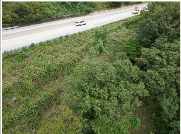
상부 성토부 전경
